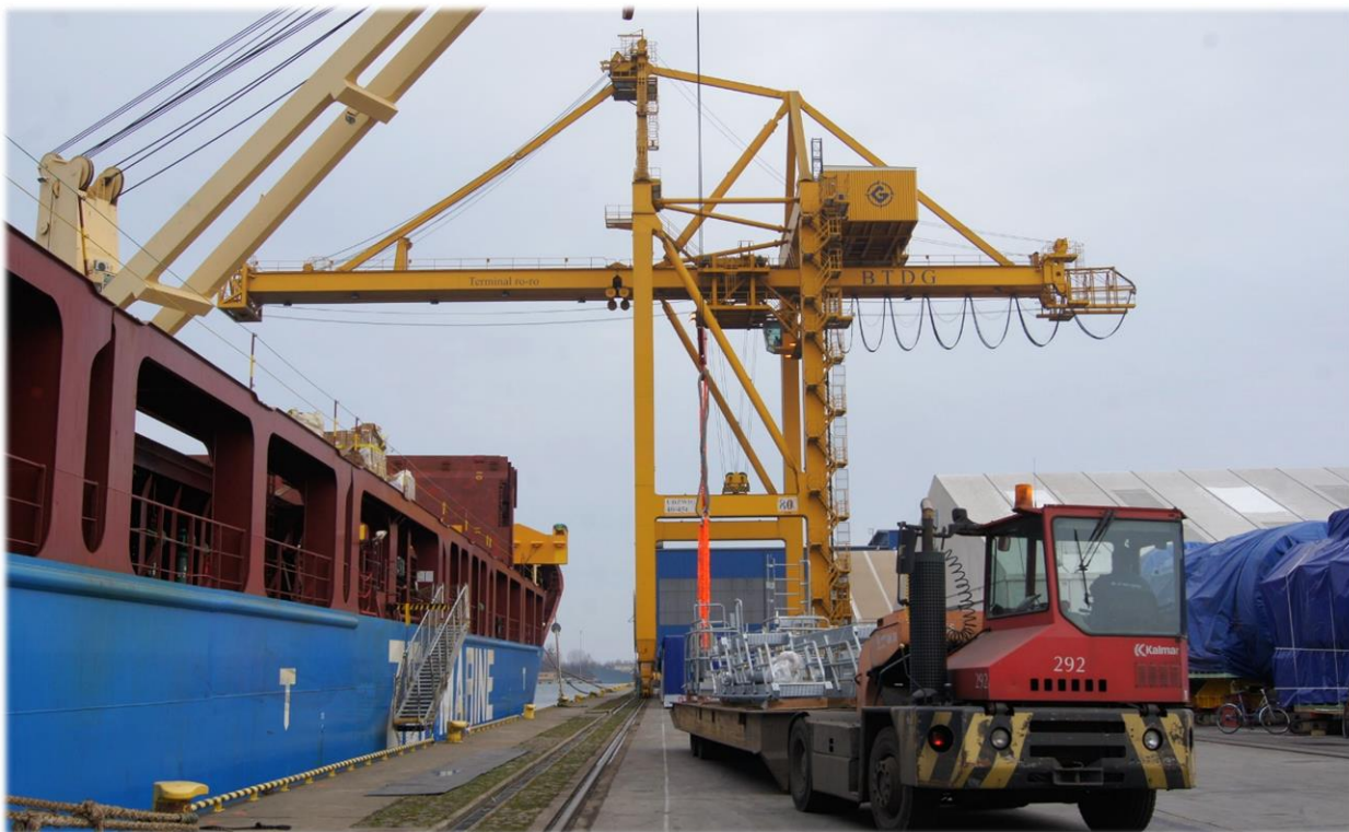
Fot. Suwnica kontenerowa na Nabrzeżu Stanów Zjednoczonych.
