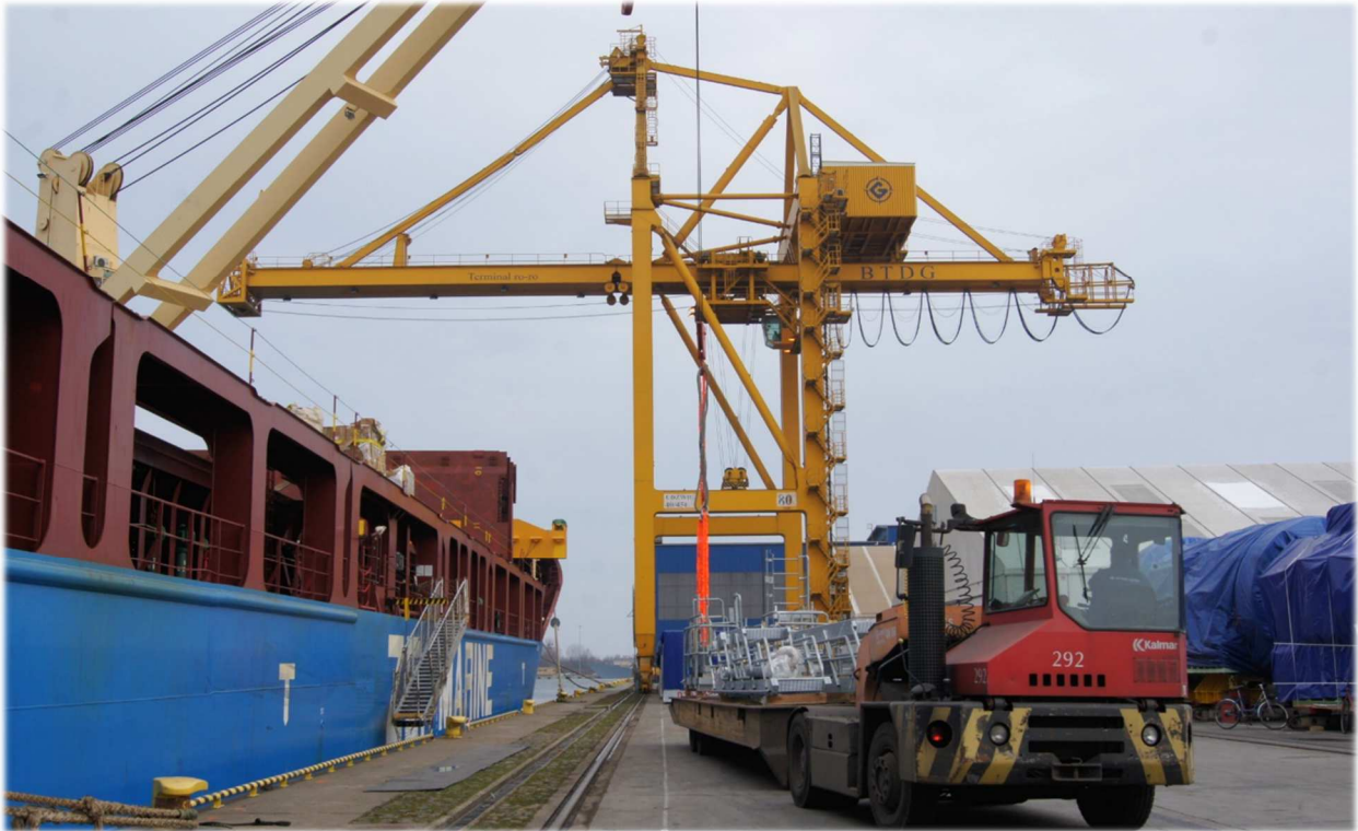
phot. Gantry crane on Stanów Zjednoczonych Quay.
