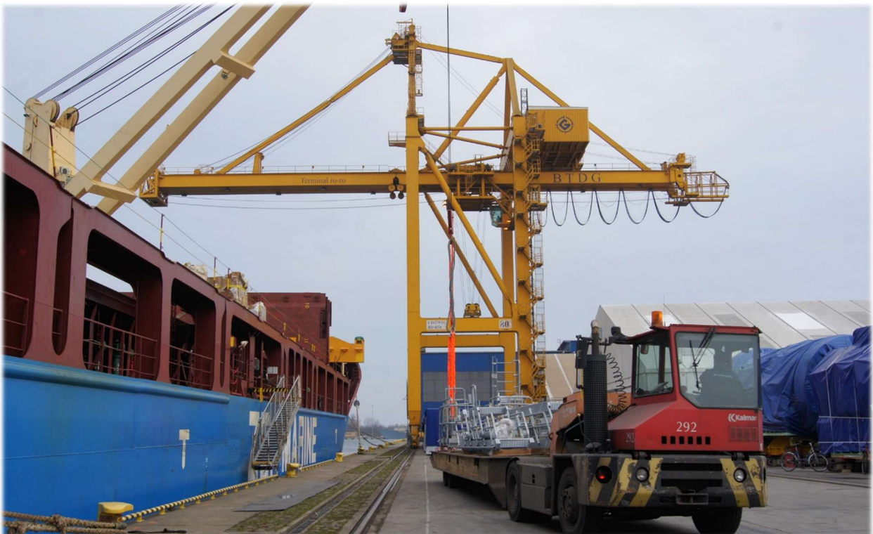
Fot. Suwnica kontenerowa na Nabrzeżu Stanów Zjednoczonych.
